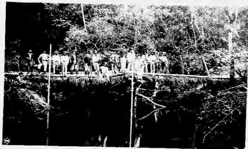
PONTE SOBRE O RIO FEIO
