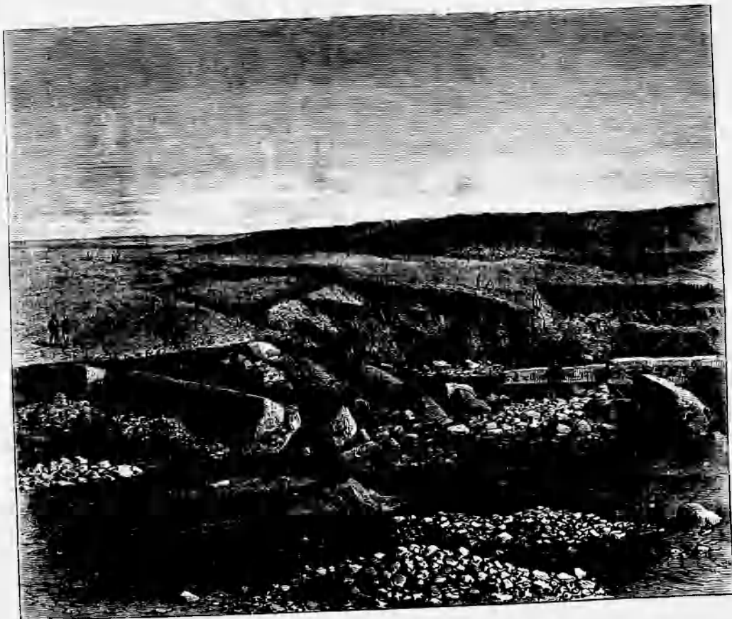
EXCAVACIONES DE TANIS
