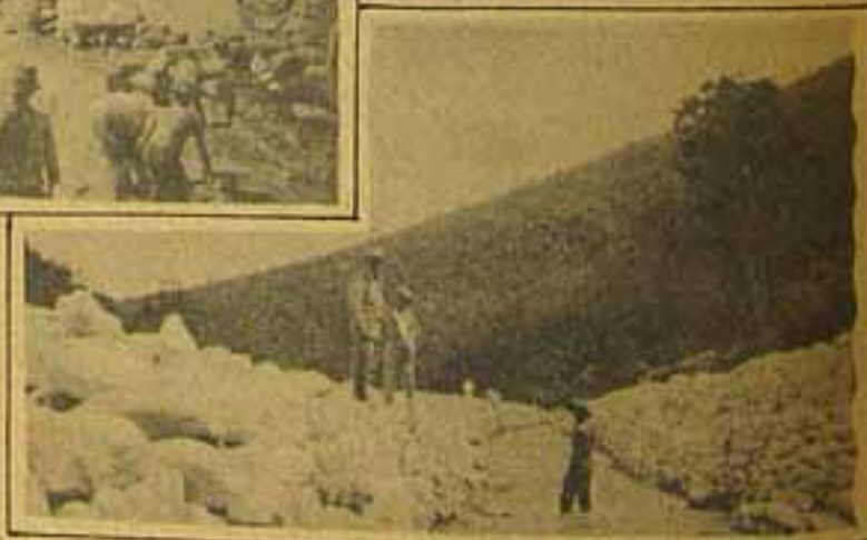
Um serviço de rebixo (canalizando as águas do rio)
