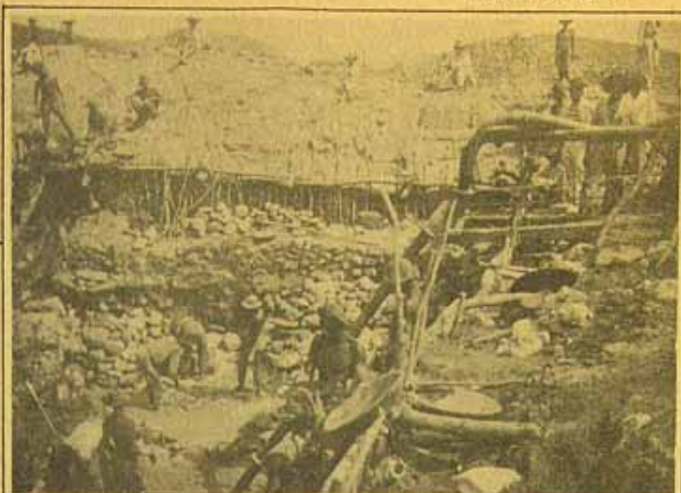
Secando água de uma cota com uma bomba a motor
