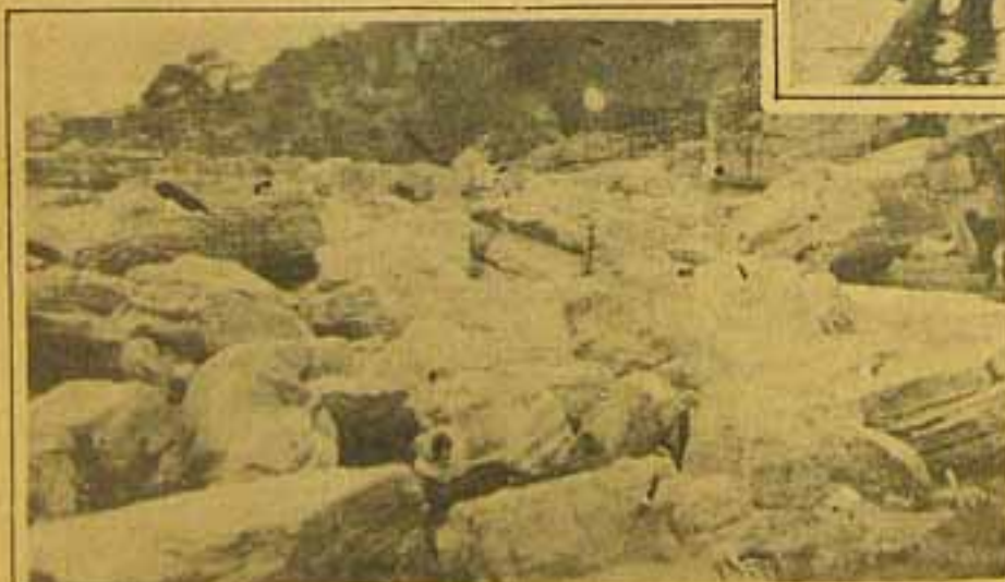
Blocos de pedras carregados a braco
