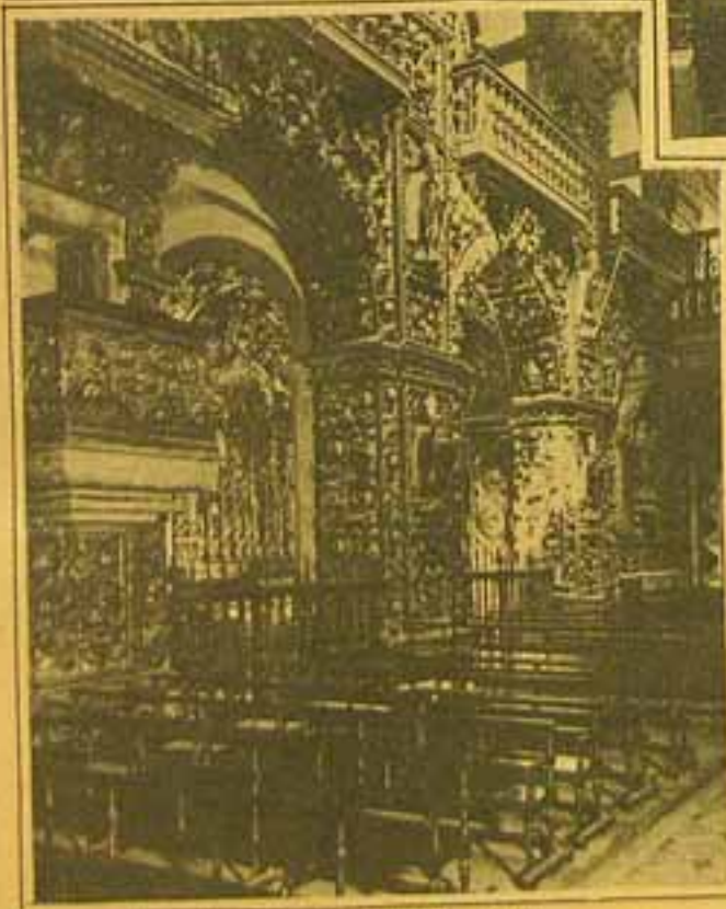
Parte da nave — Igreja de S. Bento.
