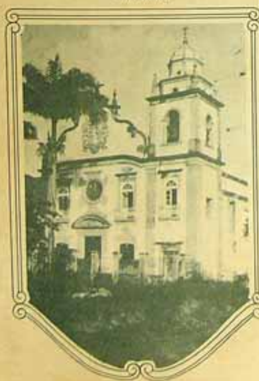
Convento de São Bento em Olinda
