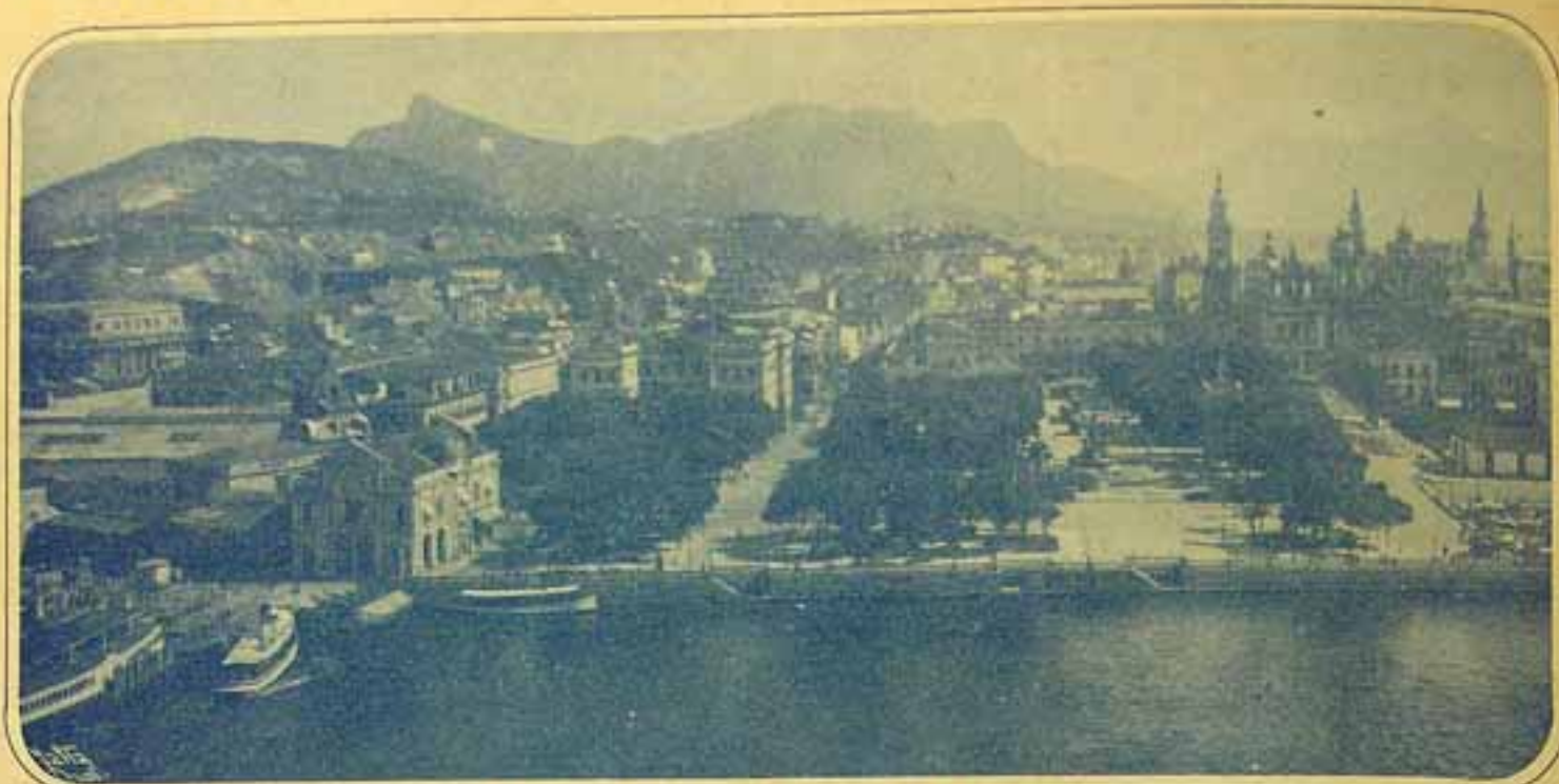
PRACA 15 DE NOVEMBRO EM BAIXO: AVENIDA MARACANÃ
