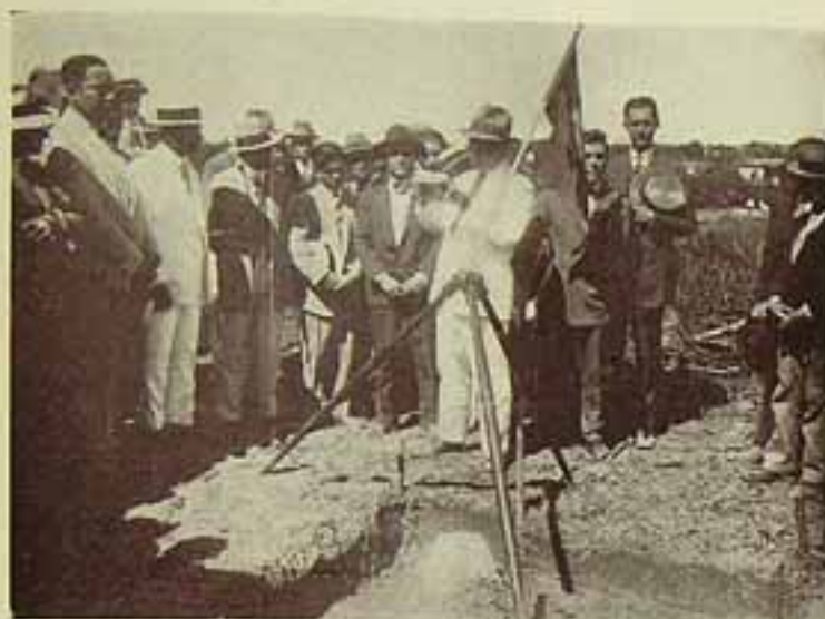
O Dr. Oswaldo de Souza e Silva, discursando, em nome da directoria do Lar Economico, por ocasião do lançamento da pedra fundamental das construções.
