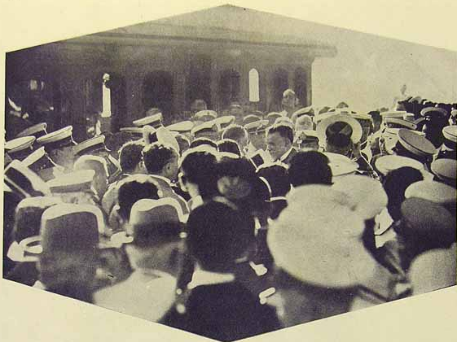
Chegada à estação Barão de Mauá.
