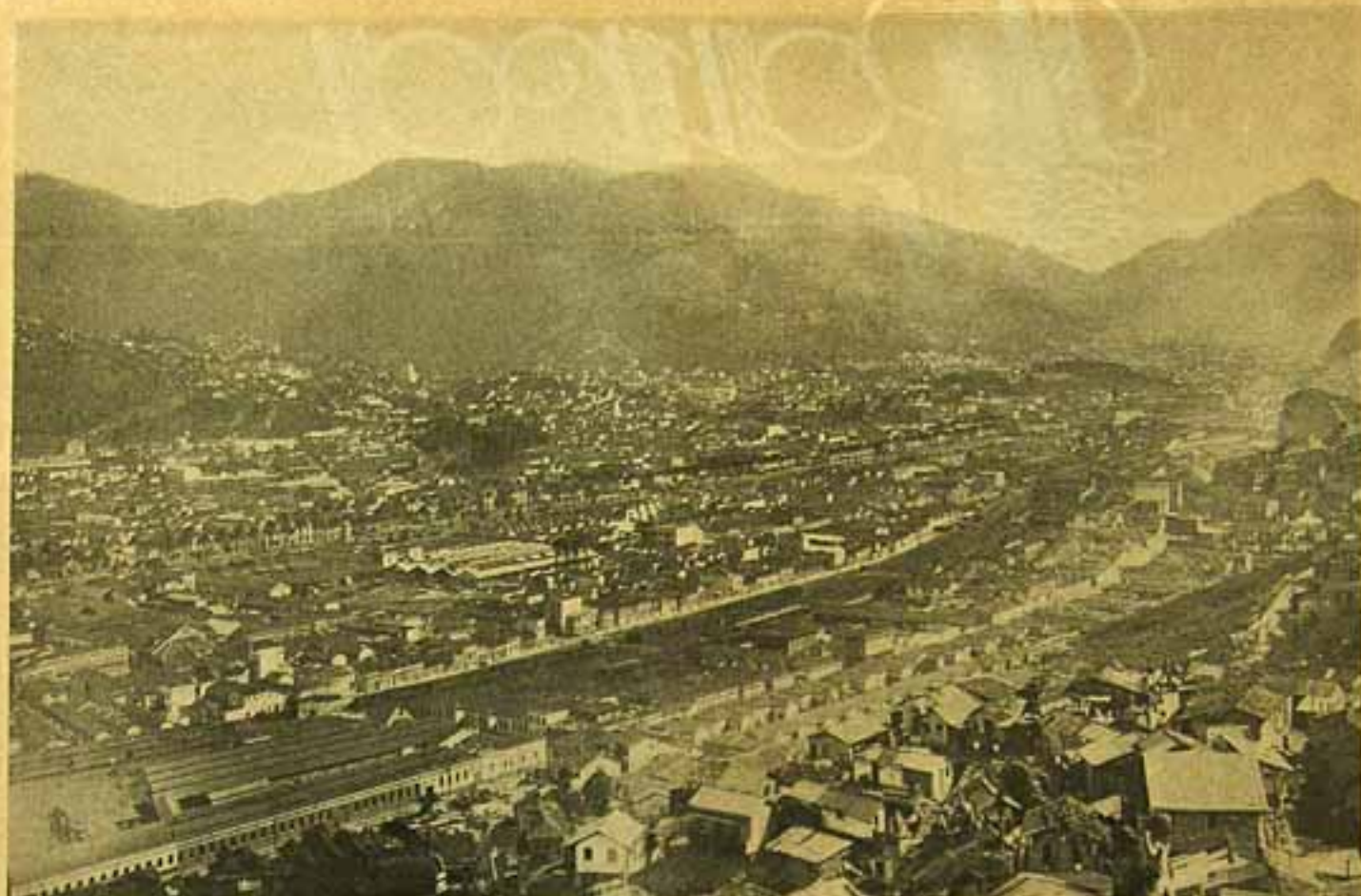
Em cima: a Avenida do Mangue, a linha da Central, a pedreira de São Diogo, as officinas da S. A. "O Malho" e os bairros que se envolvem. Em baixo: Estrada de Ferro Central do Brasil, Quartel General, Campo de Sant'Anna, Morro de Santo Antonio, Outeiro da Gloria, Guanabara, o Pão de Assucar.
