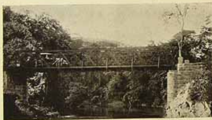
Ponte metallica do Roseiral sobre o rio das Flores, com 20 metros de vão, na estrada de automovel Santa Thereza — Barreado.
