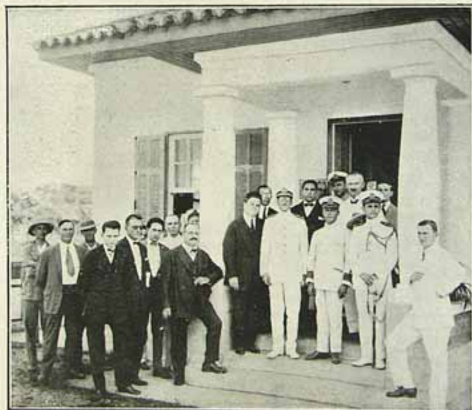
Visita do Sr. Ministro da Marinha às obras do Dique da Ilha das Cobras
