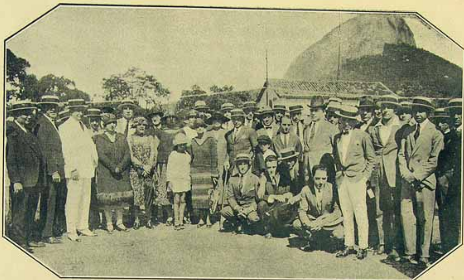
Em cima: visita da directoria e socios do C. R. Flamengo ás obras do stadium maravilhoso que está sendo construido na Gavea.
