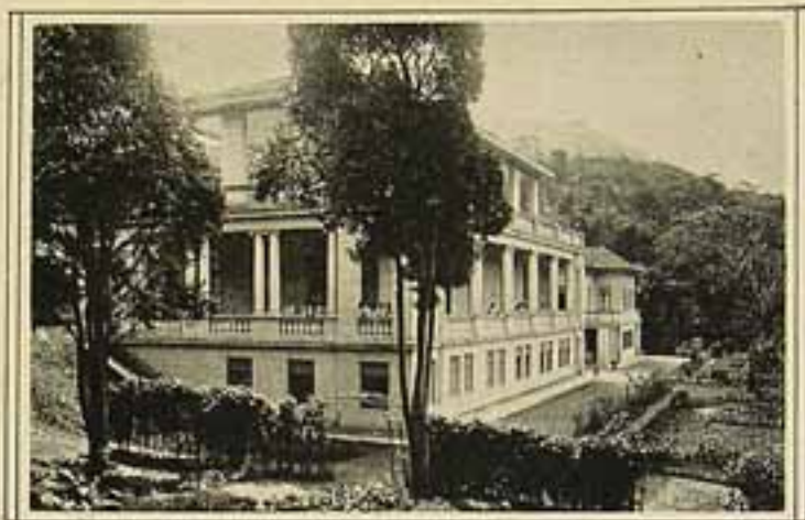
O edificio entre arvores
