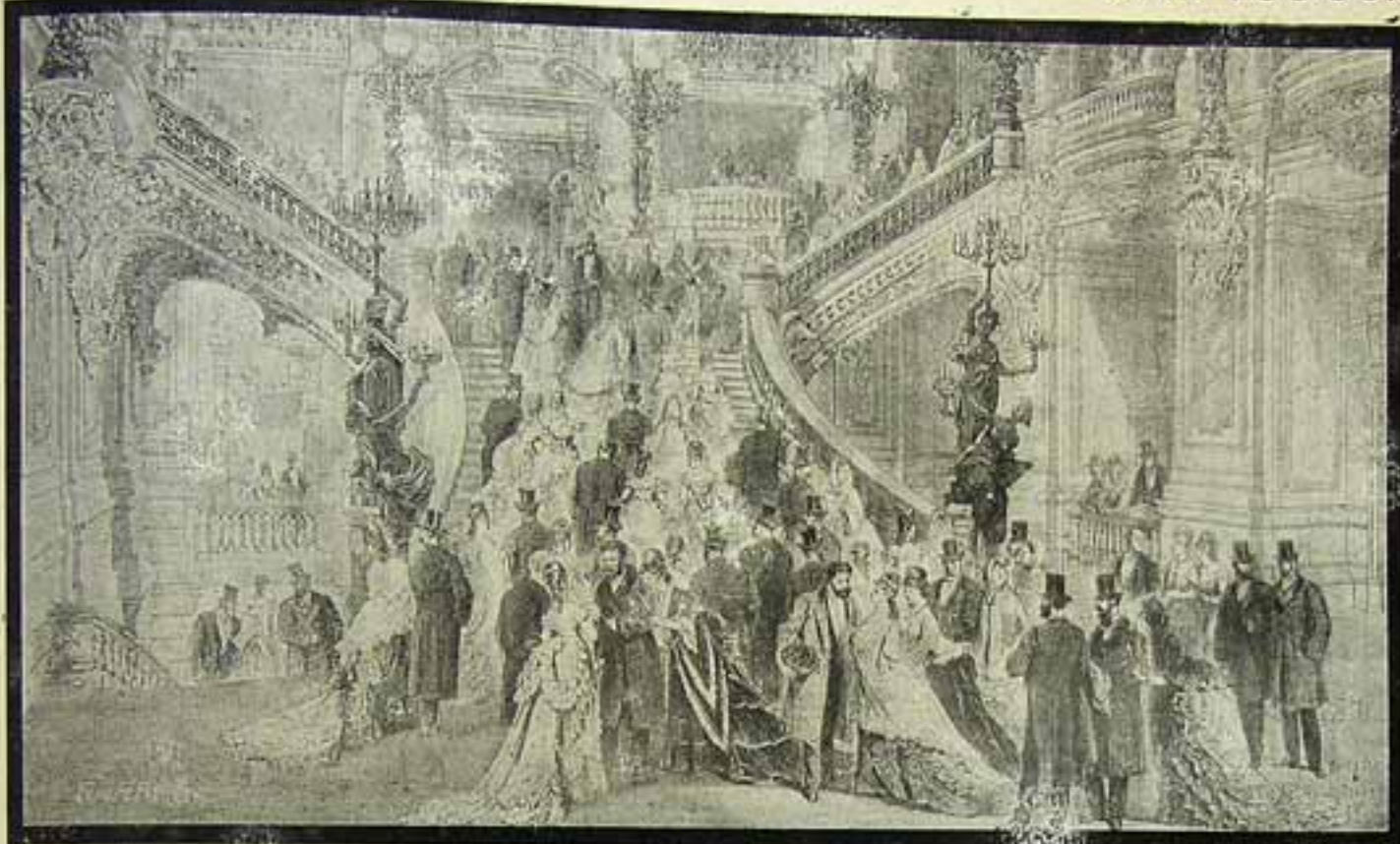
Chegada dos espectadores para a festa de inauguração da Opera, de Paris, no palacio acabado de construir por Charles Garnier.
