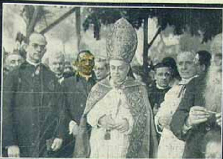
Lançamento da pedra fundamental
