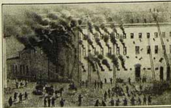
O incendio do Recolhimento do Parto em 23 de Agosto de 1789
