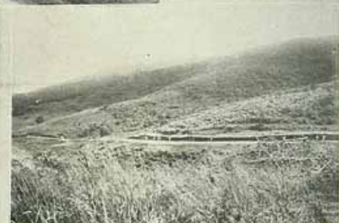
Preparo do leito da R. de Ferro Limoeiro a Umbuzeiro. Frecho pronto para receber os dormentes. Corte na mesma linha ferrea.
