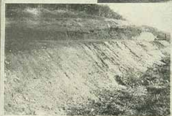
Desenvolvimento paralelo das duas estradas, de ferro e de rodagem, de Umbuzeiro a Limoeiro. Trabalhos preparatórios do leito da R. de Ferro.
