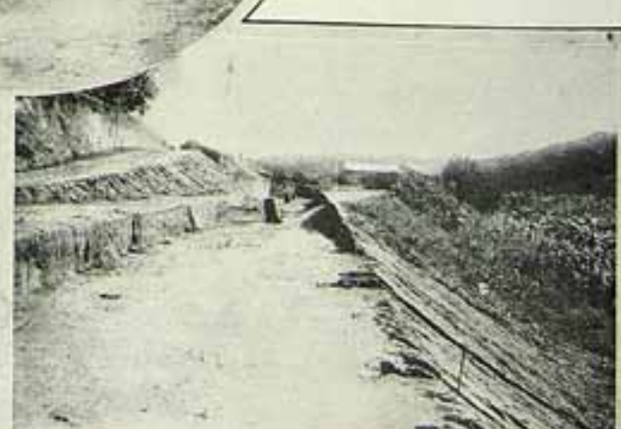
Preparo do leito da R. de Ferro Limoeiro a Umbuzeiro. Frecho pronto para receber os dormentes. Corte na mesma linha ferrea.
