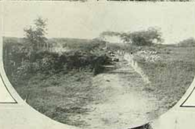
Preparo do leito da R. de Ferro Limoeiro a Umbuzeiro. Frecho pronto para receber os dormentes. Corte na mesma linha ferrea.
