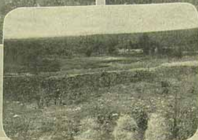
Vista da bacia que será ocupada pelas águas, concluída a barragem do Açude Pilões.
