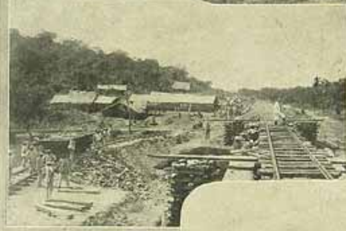
Ponte provisória sobre o rio do Peixe, por onde passa a linha que serve ao Açude Pilões.
