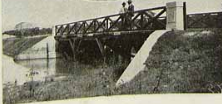
Ceará: Ponte sobre o rio Siqueira.
