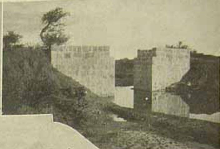
Pengões de um pontilhão da Estrada de Ferro Ceará-Parahyba.
