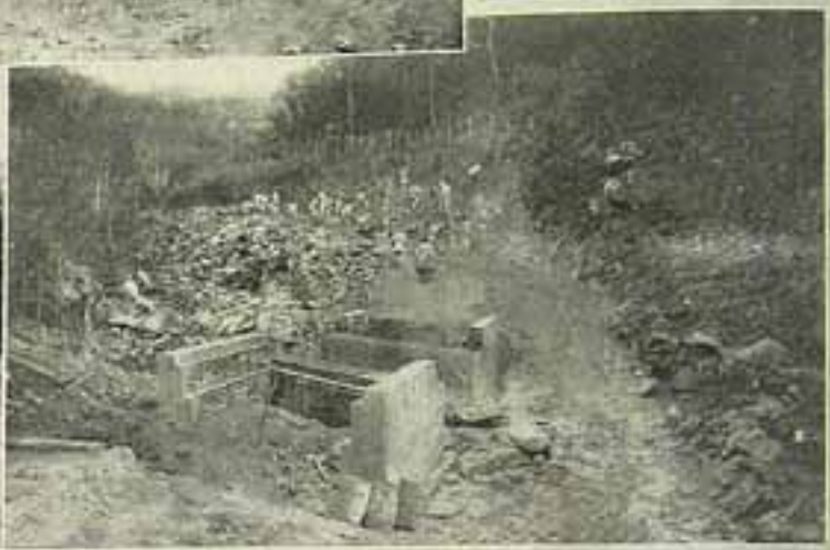
Estrada de rodagem Barra do Natuba — Umbuzeiro. Um pontilhão em construção.
