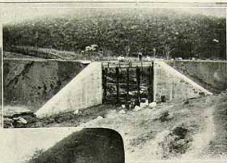
S. Bento (Paraíba) Pontilhão em construção.
