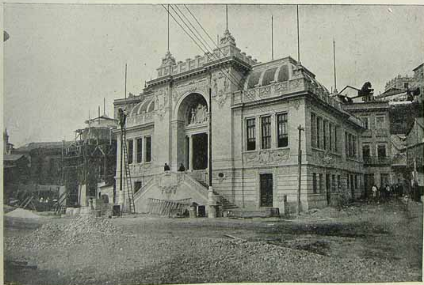
PAVILHÃO DA ADMINISTRAÇÃO, QUANDO SE RETIRAVAM OS ANDAIMES
