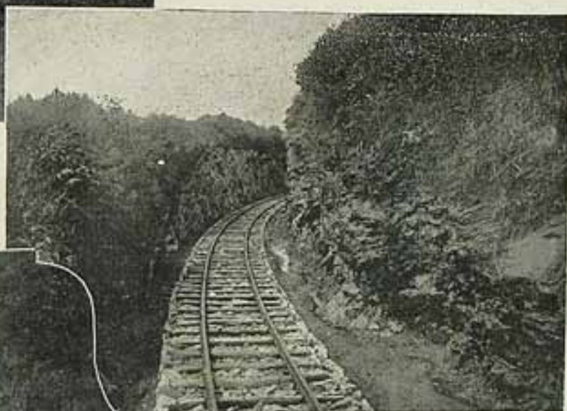
CORTE NA ROCHA E TRECHO LASTRADO.
