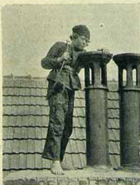
Lançando o limpa chaminés.
