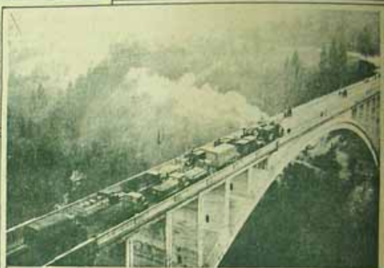
Prova de resistencia da ponte em cimento armado da Caille na Alta-Saboya (Photo Verson).
