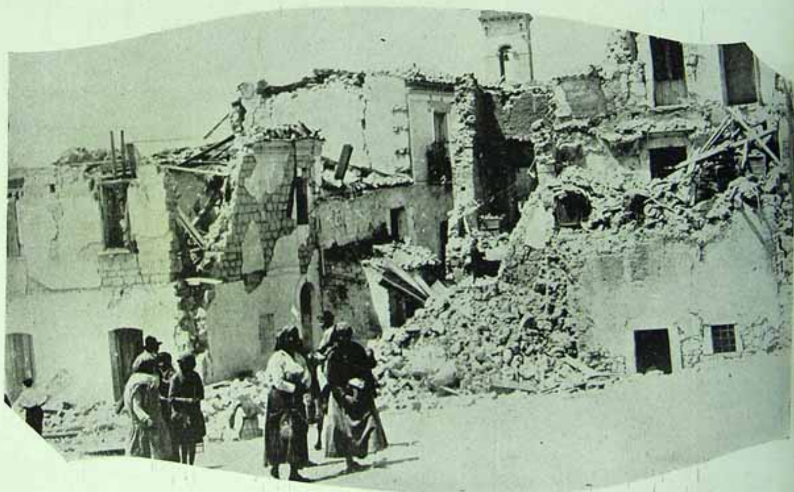
Um aspecto de Melfi, na Italia, depois do grande terremoto que abalou toda a região, ultimamente
