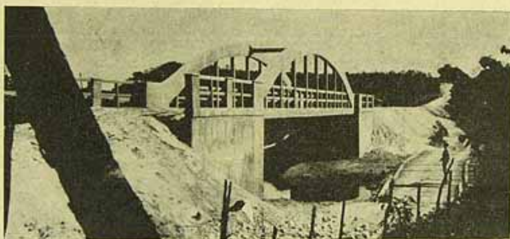
Ponte de concreto armado de 23 metros de vão sobre o Rio Jacumirim, na Estrada de Rodagem Camassary a Matia de S. João.
