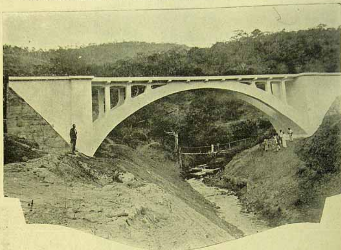
Ponte de cimento armado, de 25 metros de vão livre, sobre o Rio Provisão. Em baixo: a ponte sobre o Rio Jequiricá, também de cimento armado e com o vão de 30 metros, na Villa de Mutipe, construída pela Prefeitura do Estado.
