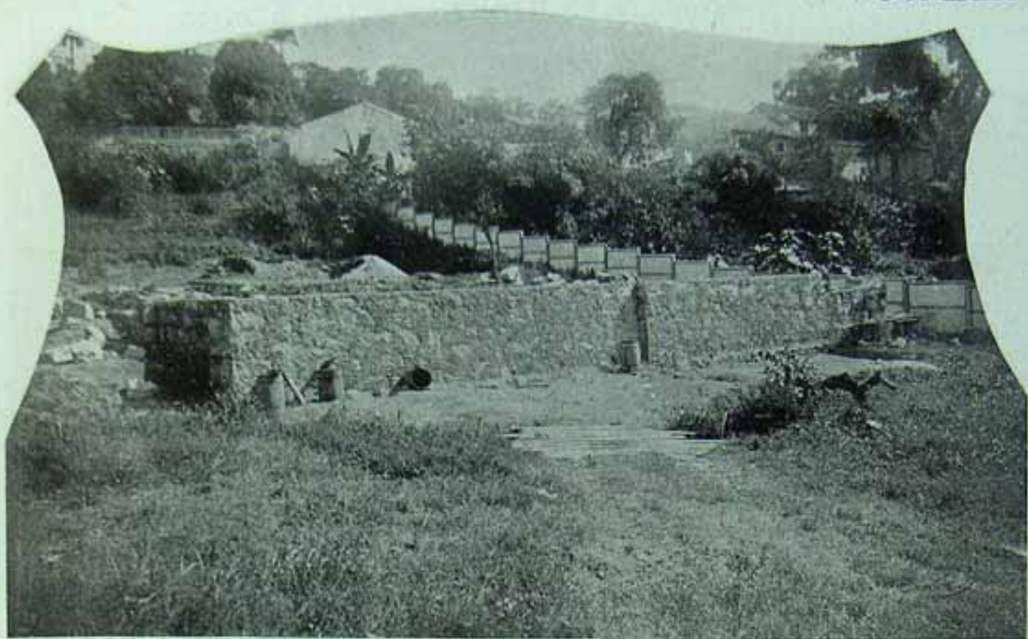
Alicerces do palco para montagens de interiores, que medem 20 x 30
