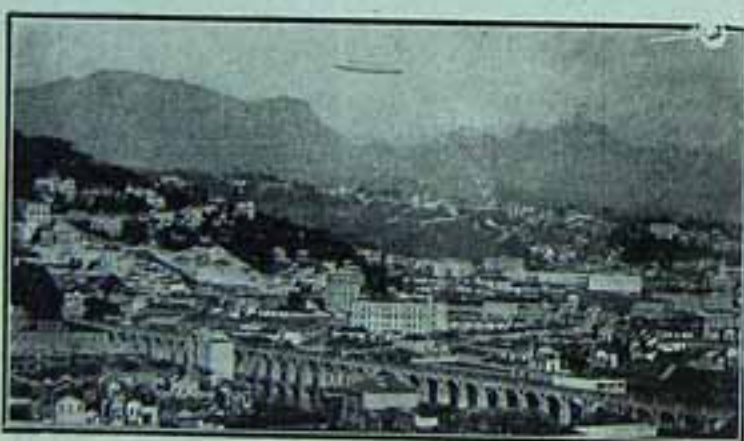
Passando sobre o Andarazy Grande.
