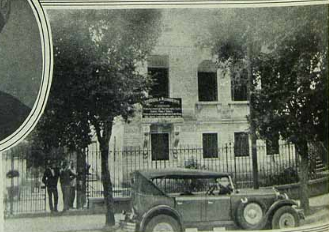
O amplo edificio em que funciona o Gymnasio Santa Thereza, dotado com todos os requisitos da pedagogia moderna e, no medalhão, o seu director, Dr. Alcides Rosa.
