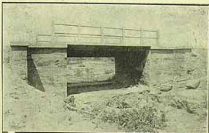
Ponte de 6m.00 de vão na Estrada de Rodagem de Campina Grande a Souza — Kilometro 34.
