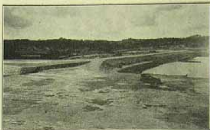
Estrada de Rodagem Bôa-Vista-Cabacciras-Cuchicholo — Açude Brabo — Atterro e barragem.
