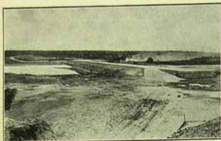
Estrada de Rodagem Bôa-Vista-Cabacciras Cuchicholo- Açude Brabo — Atterro e barragem — Kilometro 33.
