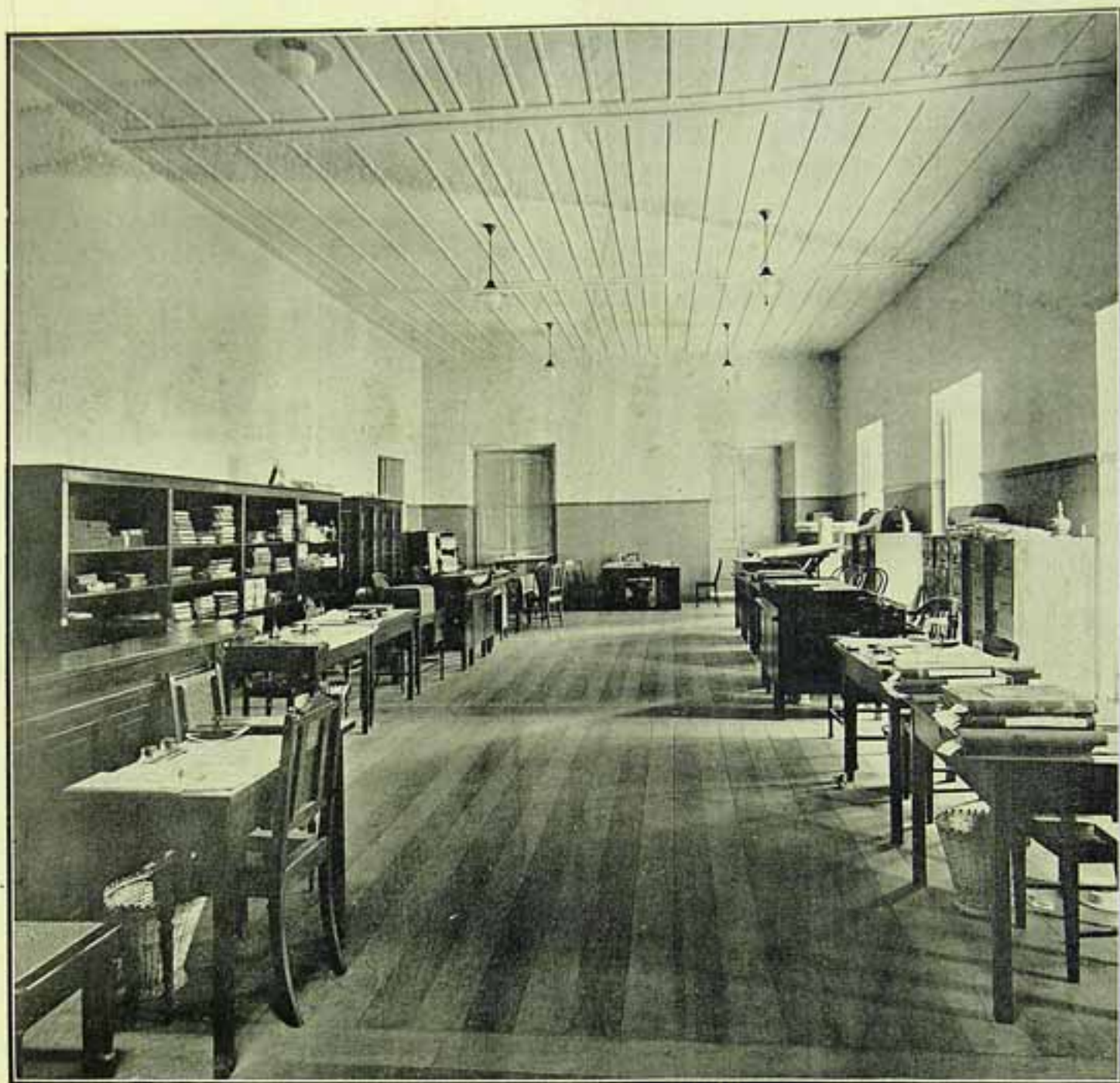
A Secretaria remodelada na actual administração
