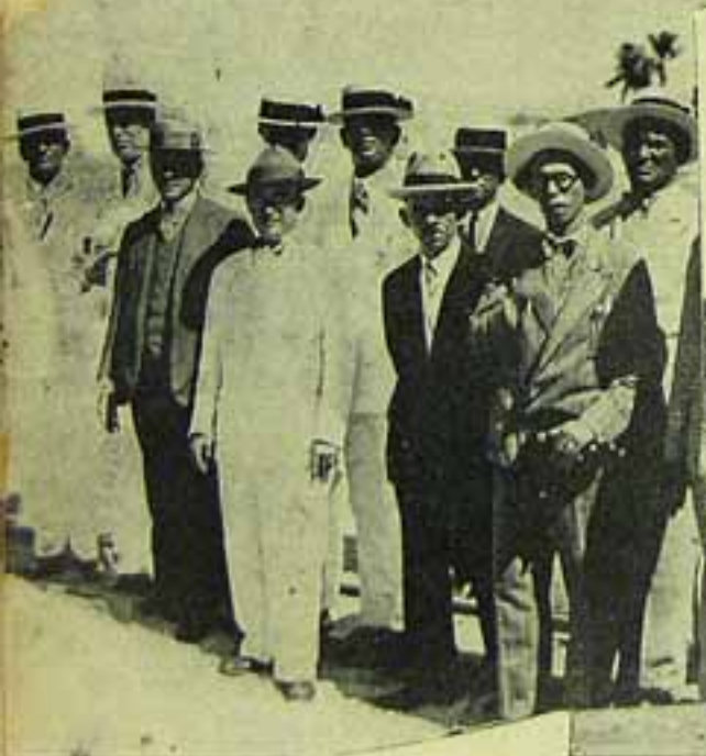
deral de Portos, e sua comitiva, ladoados em inspecção ás obras do prolongamento Boulevard.
