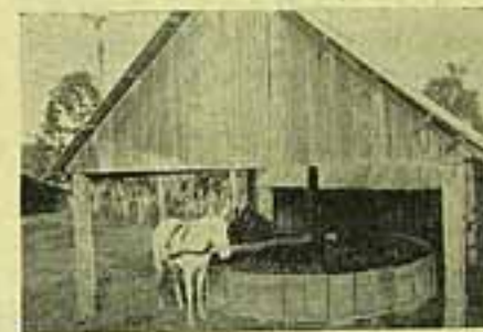
A "cancha" ou moinho — O animal movimenta o aparelho que faz a selecção das folhas, separando-as dos galhos e pulverizando-as. Os fazendeiros mais adeantados têm "canchas" movidas a electricidade. Da "cancha", a cancheada é conduzida para os moinhos de Curitiba.
