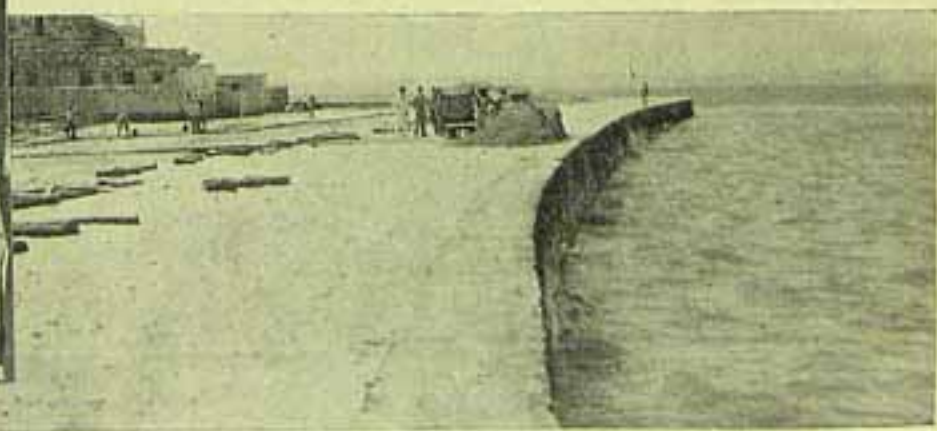
Prolongamento do Cãoz do Boulevard na cidade de Itaparica. Importante obra de defesa da cidade contra a furia do mar, executados sob o patrocínio do re- nador Miguel Calmon e deputado Antonio Calmon.
