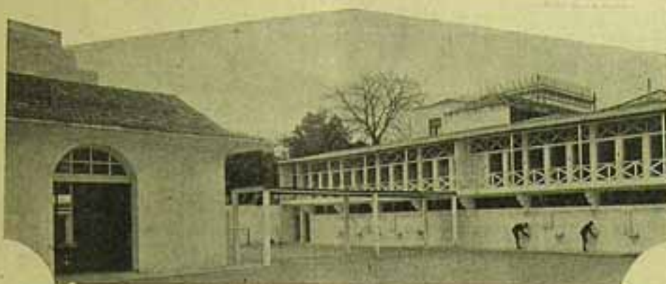
O Edifício Sanitário, com 30 cabines, 30 water-closets, os lavatorios e os bebedouros. Os bebedouros americanos Crane vieram especialmente de New York. A agua potavel é recebida na caixa superior da torre á esquerda, e dali passa para os filtros na caixa n. 2, depois de convenientemente refrigerada; dest'arte o Collegio resolveu o problema de supprimir as canecas.
