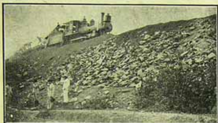
Piauhy — Trem de lastro reforçando um aterro na E. F. P. T.
