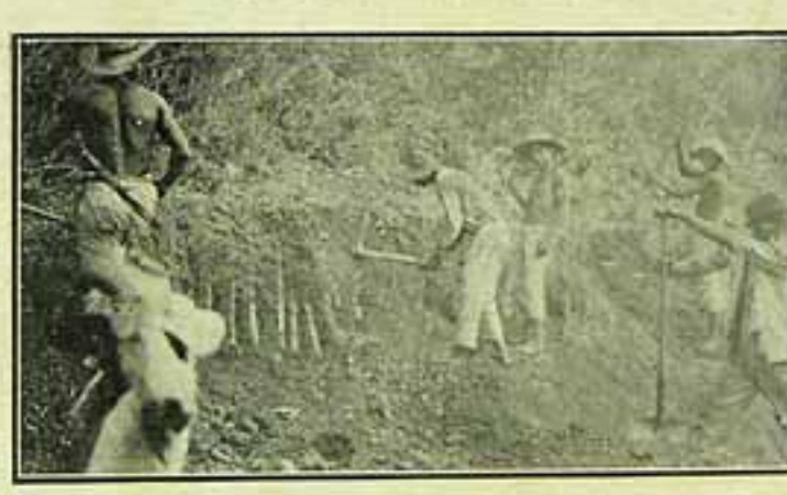
Piauhy — Trabalho de construção da estrada de ferro na Serra dos Dois Irmãos.
