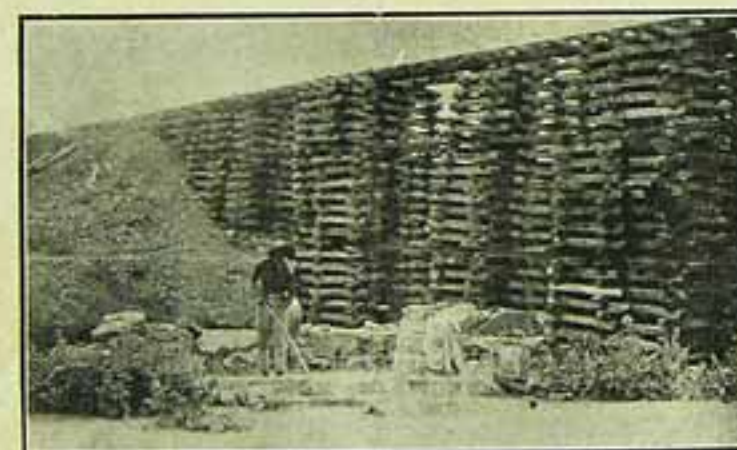
Piauhy — Ponte provisória da E. F. P. T., em Mafrense.
