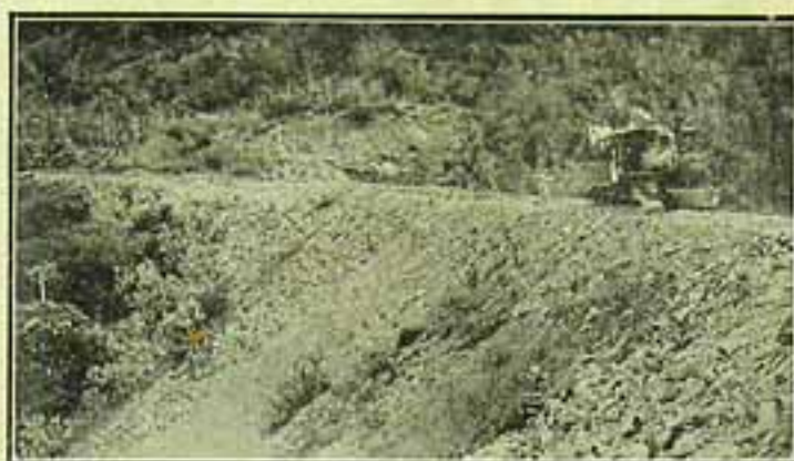
Piauhy — Trecho denominado "ferradura", na E. F. P. T., construído de pedra por falta absoluta de terra.
