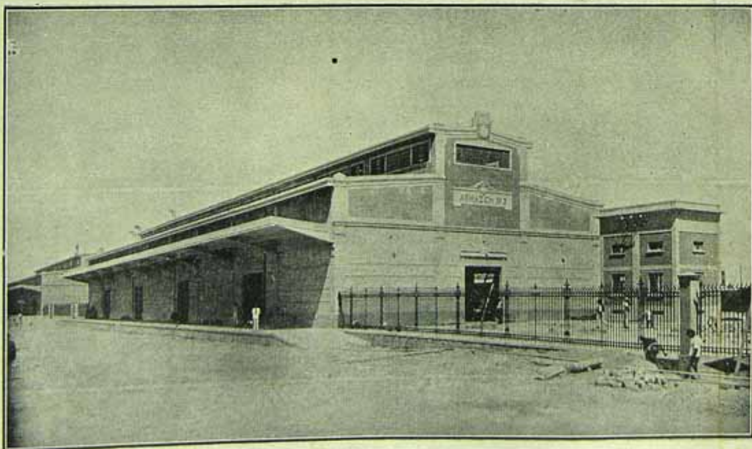
Rua do Porto — parte interior — vendo-se um dos armazéns do cães
