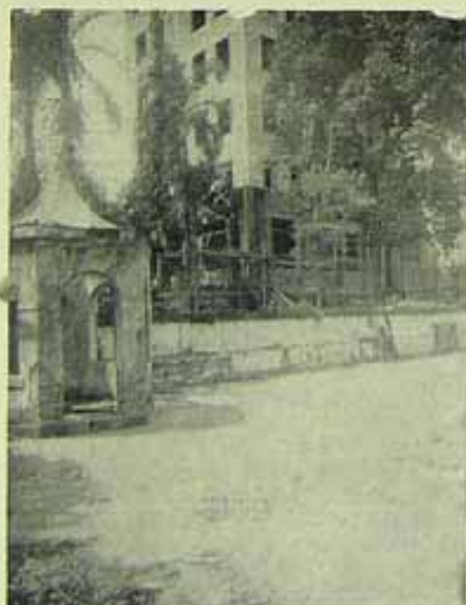
Outro aspecto da fundação
