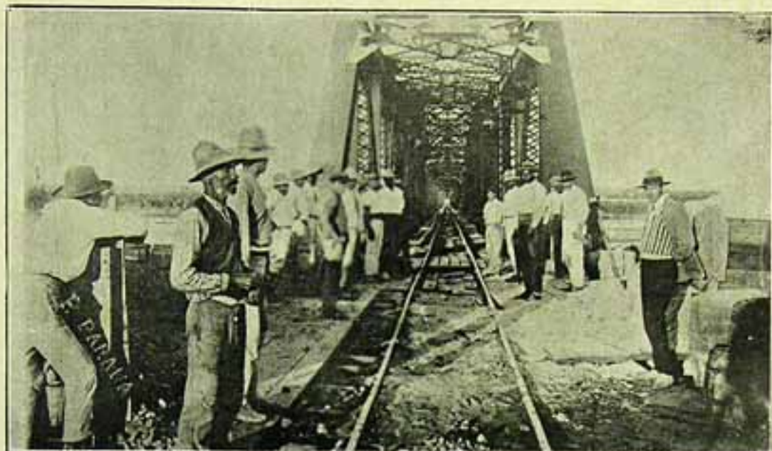
3) Matto Grosso — Ponte da Naveste sobre o rio Paraná.
