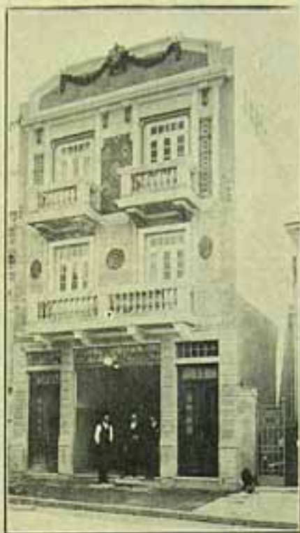
Vista da fachada do novo edificio
