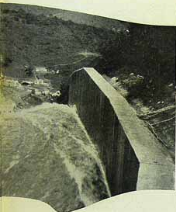
O canal tem uma capacidade de 210 m 3 cubicos por segundo.
