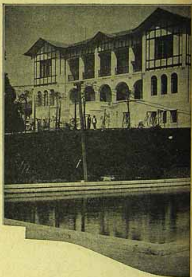
Sêde da Directoria de Industria Animal, obra do lado: o pessoal tecnico, laboratorio de bacto, salão de conferencias, museu, camaras frigorificas de laticios
