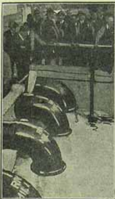
As boccas das possantes bombas que aspiram 120.000 litros de agua por dia.
