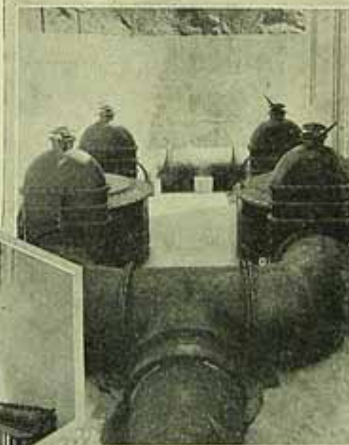
Saturadores de água e cal na casa de tratamento químico.
