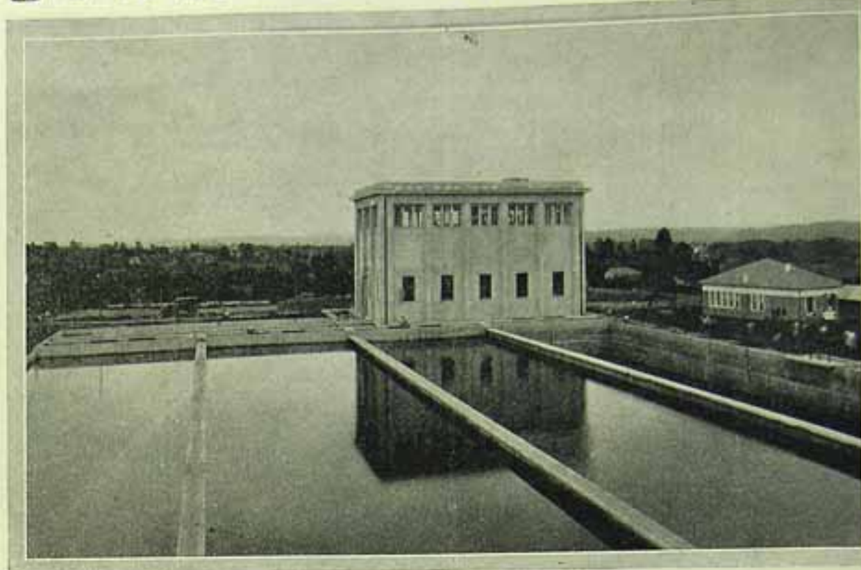
Os decantadores e a casa de tratamento químico.
