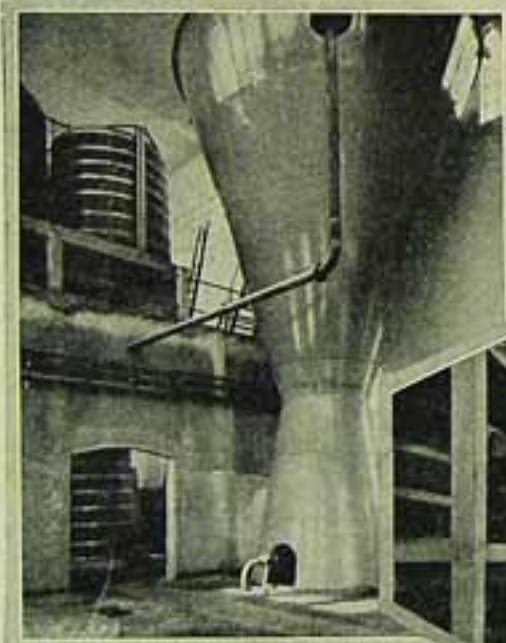
Os tanques de decantação e a casa dos filtros.
