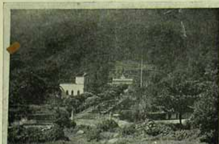
Vista geral do edifício.
