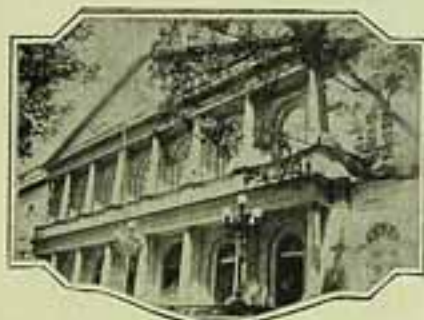
Fachada da Santa Casa
