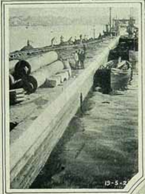
No medallhão: o Dr. Hildebrando Góes, Inspector de Portos e Canaes. Em baixo: varios flagrantes das obras do caes do Porto, vendo-se o trecho de 90 metros que falta para a conclusão da muralha e algumas phases do serviço.
