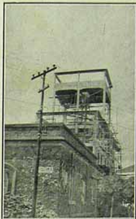
sados, é o ex-mercado da Boa-Vista, transformado em almoxarifado da Prefeitura.
