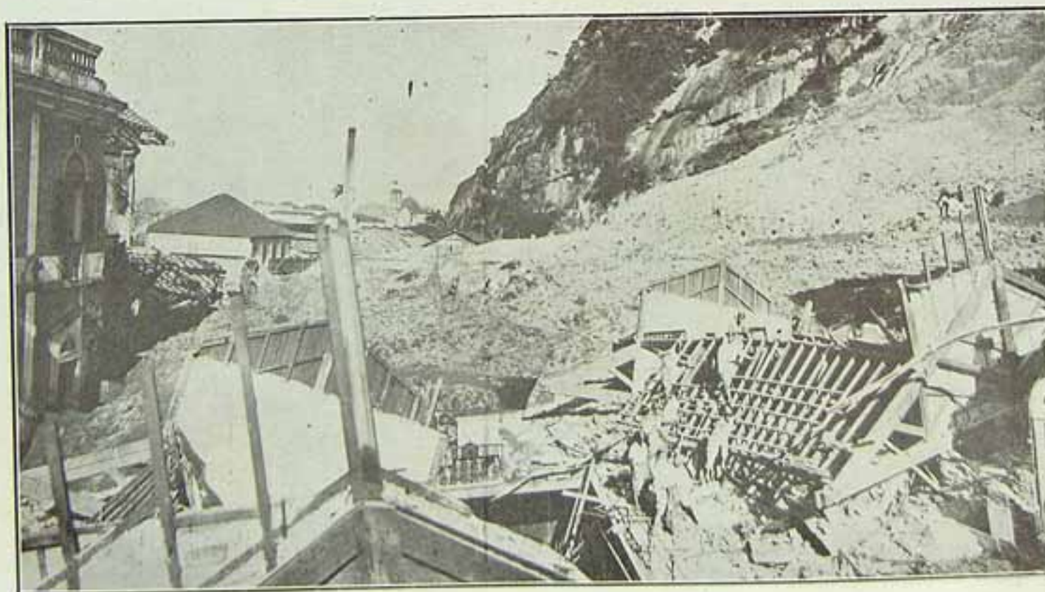
Os ultimos desmoronamentos do Monte-Serrat, vendo-se grande parte dos escombros da Santa Casa — Santos
