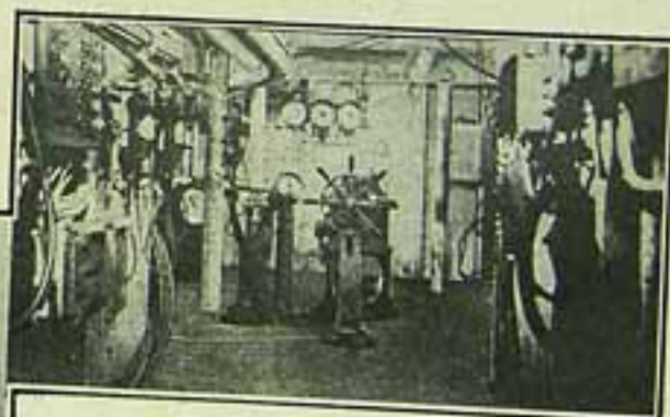
Sala de manobras
