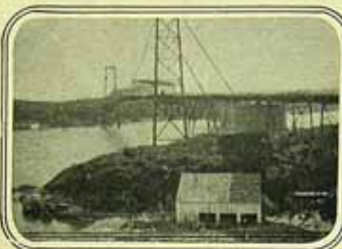
A ponte suspensa em Florianópolis.
