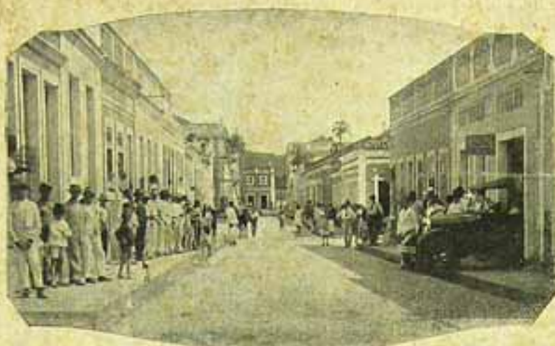
Rua Vigário Loureiro, na cidade de Viosa, Estado de Alagoas, calçada ultimamente a paralelepípedo.
