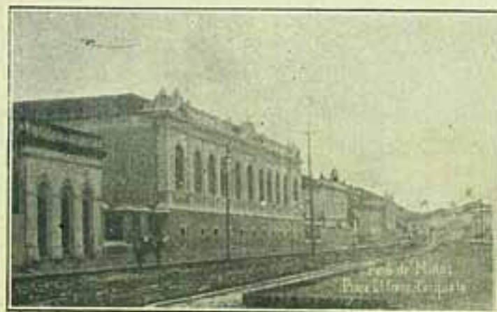
Pará de Minas — Praça Cel. Franc. Torquato.
