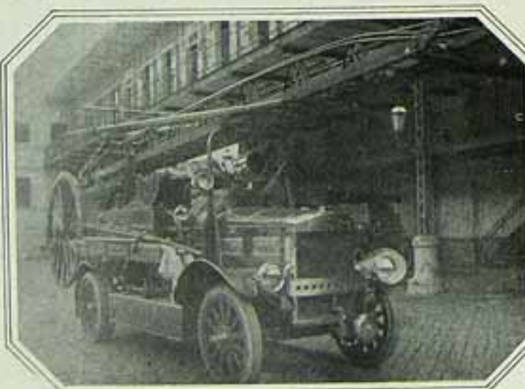
AUTO-BOMBA DE 1º socorro — Esta viatura, uma das ultimamente adquiridas, é sufficiente para extinguir um incendio de proporções regulares com 5 agulhetas, visto que conduz todo o material e pessoal para tal fim, inclusive agua para extincção de incendios em início.
