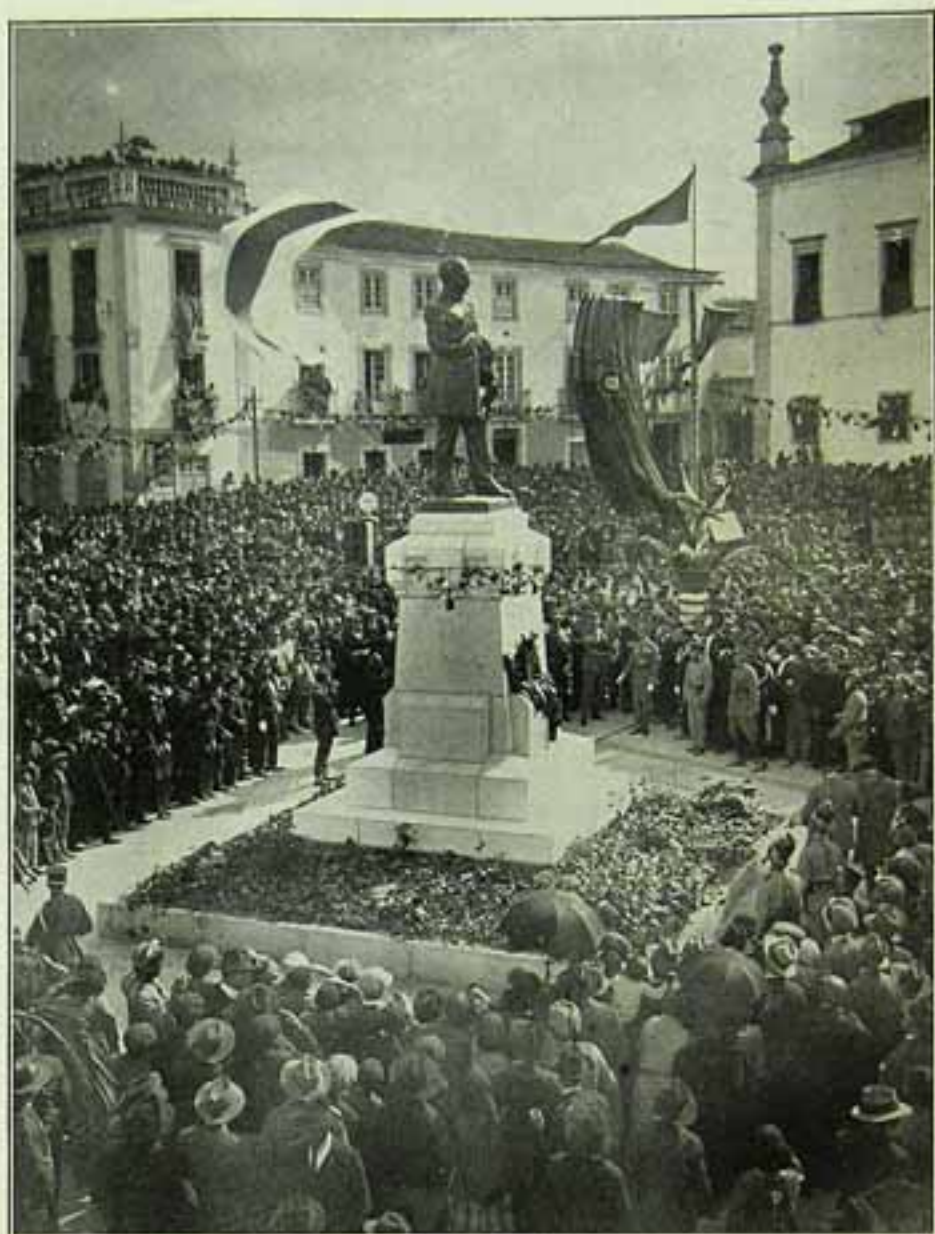
Inauguração do monumento ao general marquez de Sá da Bandeira, na cidade de Santarém.
